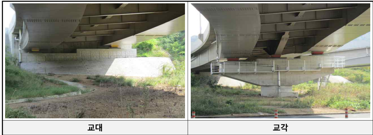
[교대 및 교각 전경]
