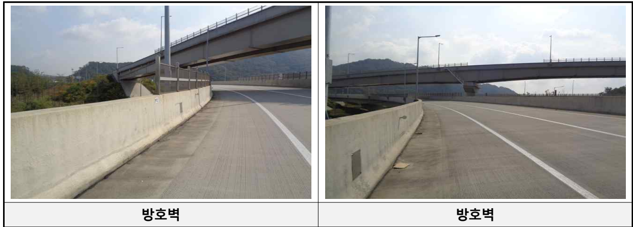
[방호벽 및 방음벽 전경]
