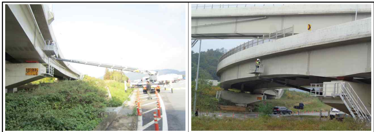
[고소작업차를 이용한 근접조사 실시]
